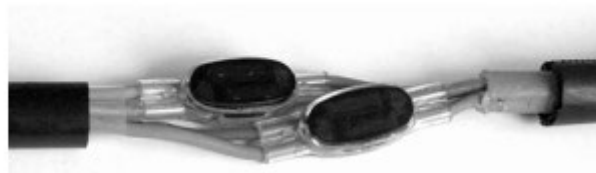
Рис. 2. Смонтированные жилы кабеля КСПП
