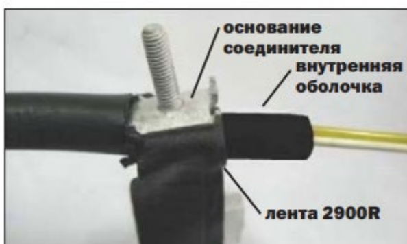
Рис.8. Установка соединителя
