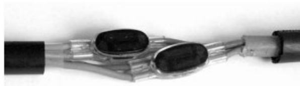
Рис. 2. Смонтированные жилы кабеля КСПП
